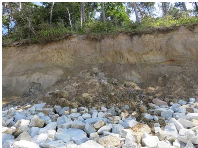
Fotografia 1. Fragment ściany klifu z obrywami materiału na opaskę narzutową
