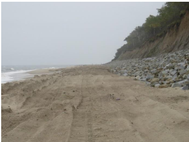
Fotografia 12. Zakończona budowa strony wschodniej odcinka opaski narzutowej i jej połączenie z istniejącą opaską z 2013/2014 r. W oddali widoczna zatoka erozyjna na zakończeniu grupy ostróg ( październik 2017 r.)
